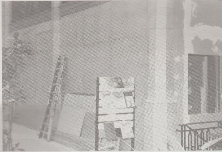
De eerste barricades staan er. De ladders ook. De boormachines komen eraan.
